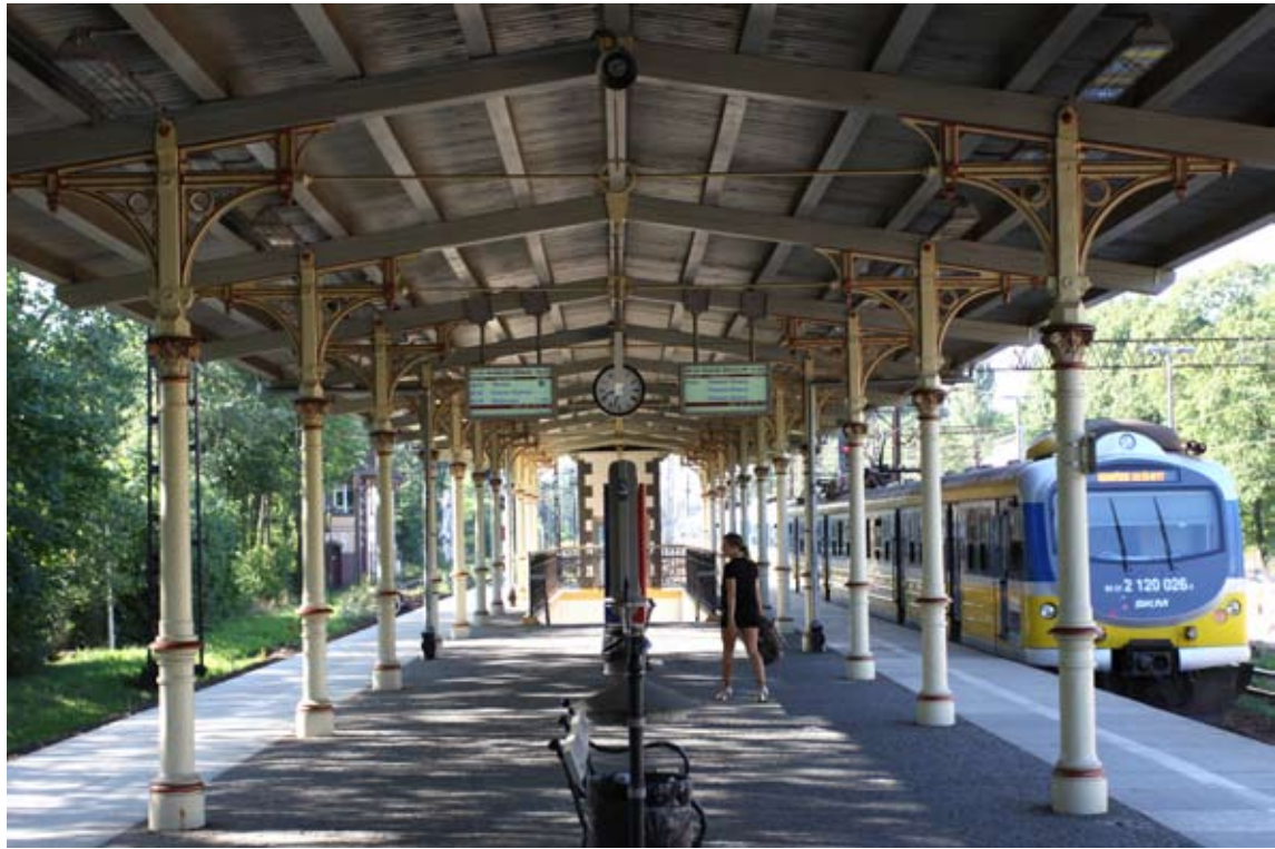
Zmodernizowany Dworzec SKM w Sopocie Fot. MZKG
