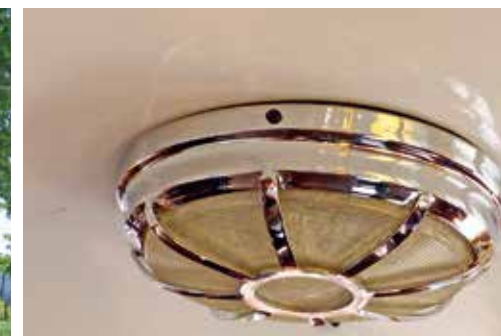
Sufitowe plafony utrzymane w modernistycznej stylistyce
