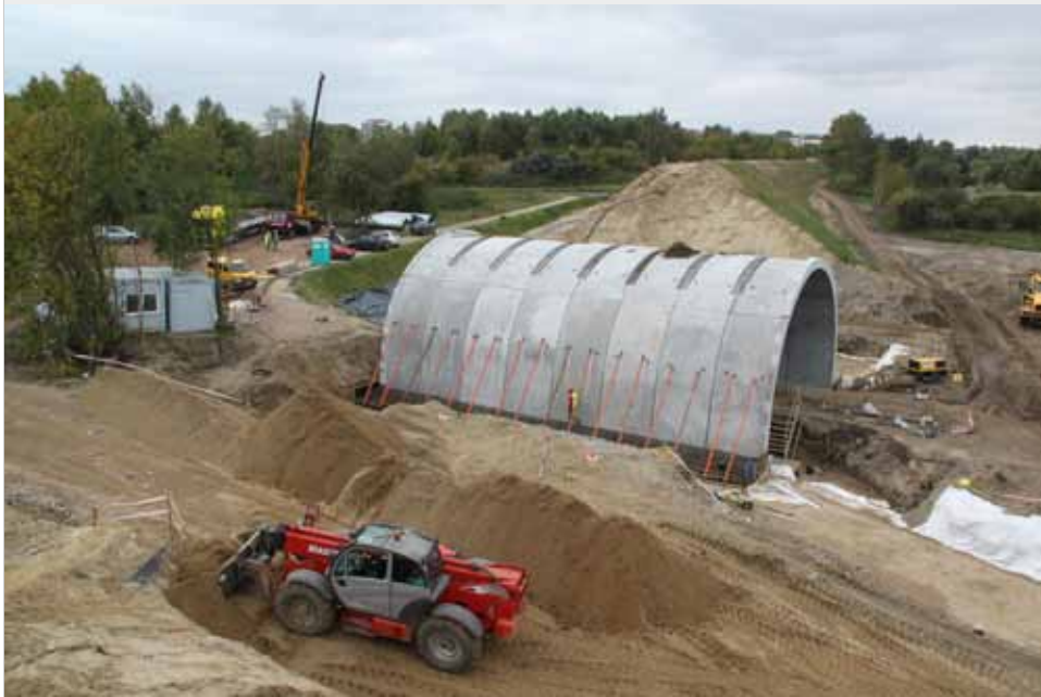
Fot. 3. Budowa przepustu pod nasypem kolei metropolitalnej. Materiały Pomorskiej Kolei Metropolitalnej S.A.
