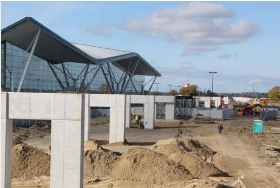
Fot. 2. Budowa kolejowej estakady przed budynkiem Portu Lotniczego im. Lecha Wałęsy. Materiały Pomorskiej Kolei Metropolitalnej S.A.
