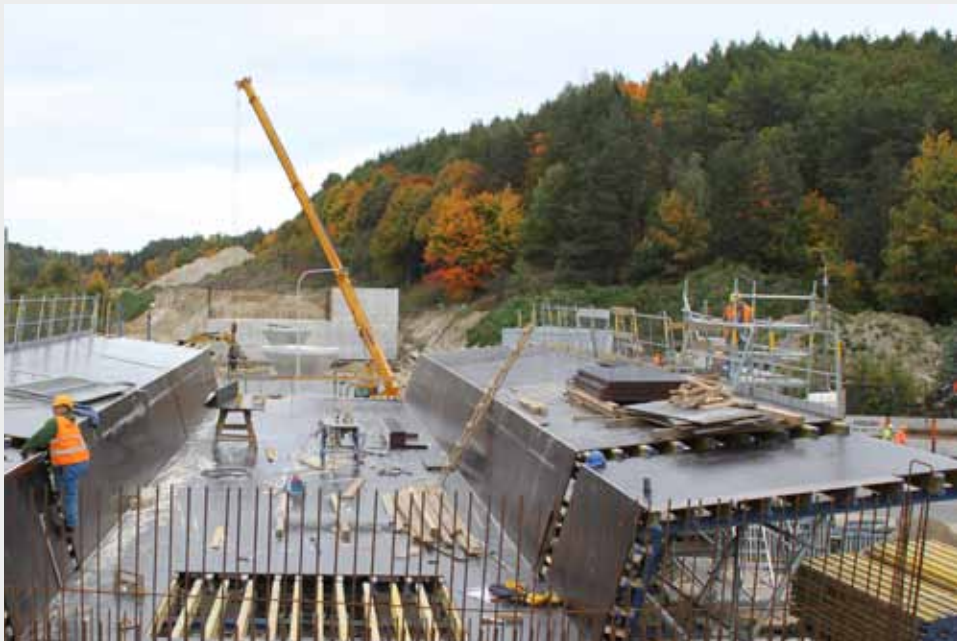
Fot. 4. Wiadukt PKM „przerzucany” nad ciągiem ulic Rakoczego-Potokowa w stronę przystanku „Brętowo”. Materiały Pomorskiej Kolei Metropolitalnej S.A.
